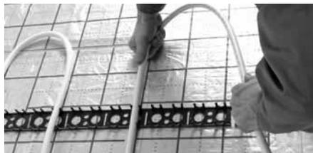
En commençant par le collecteur, clipser le registre de tuyau dans la forme souhaitée dans les rails de calage xnet.
