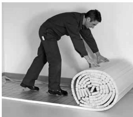
**Poser en bloc un rouleau d'isolant xnet** jusqu'à 8 m<sup>2</sup>. Commencer dans le coin de pièce gauche, la bande adhésive à recouvrement étant orientée vers le mur. La piste suivante recouvre avec sa bande à recouvrement la piste précédente. Couper exactement aux dimensions de la pièce avec le cutter xnet.
