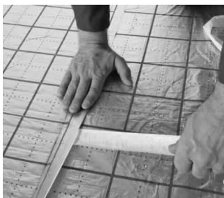
Appliquer le produit résiduel sur le mur gauche et le raccourcir du côté du mur avec le cutter xnet pour le déploiement de la grille de découpe. Raccorder un nouveau rouleau bout à bout et garantir si nécessaire par une découpe appropriée le déploiement de la grille de découpe.
