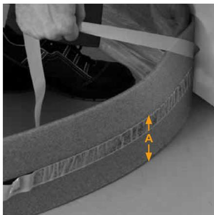
1. Poser les bandes isolantes de rive sur le sol brut. Retirer le film protecteur de la bande adhésive sur la face arrière et l'appliquer contre le mur pour la fixer.
