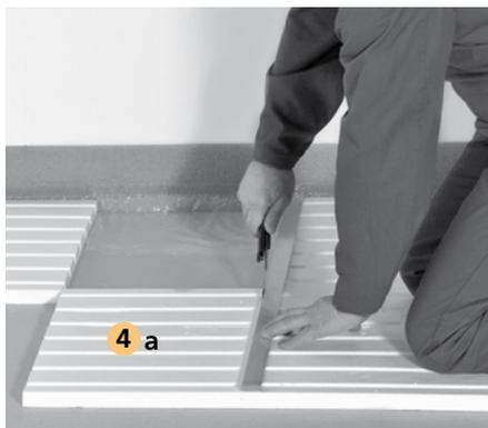
Découper l'avant-dernière plaque posée à sec comme élément d'ajustage **4** a et l'insérer.
