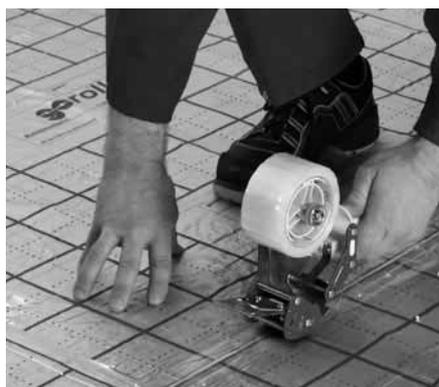
Coller les joints transversaux bord à bord avec la bande adhésive du dérouleur de bande autocollante xnet. Au niveau des joints longitudinaux, retirer le film protecteur de la bande autoadhésive du film recouvrant et coller aussi de façon étanche les joints.
