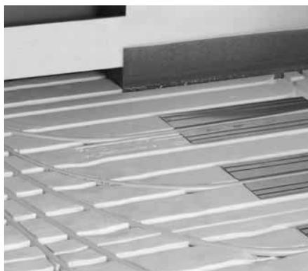
**Déroulement sans tension et sans torsion des tuyaux** d'interconnexion xnet à l'aide du dévidoir pour pros xnet directement à partir de l'emballage. En commençant par le collecteur, clipser le tuyau d'interconnexion 14 x 2 dans la forme souhaitée dans les tôles de conduction de la chaleur. En cas de réalisation de coudes de tuyau sans outil de cintrage, respecter un rayon de courbure minimum de 70 mm.
