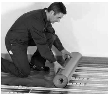
**Avant la pose des plaques (chape),** rincer individuellement tous les circuits de chauffage et effectuer un contrôle de pression sur la base du rapport d'essai et des normes SN EN 1264-4 (voir page 62).
