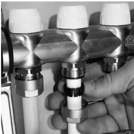
Raccordement du tuyau d'interconnexion xnet au moyen d'un raccord à bague de serrage sur le collecteur FBH xnet.
