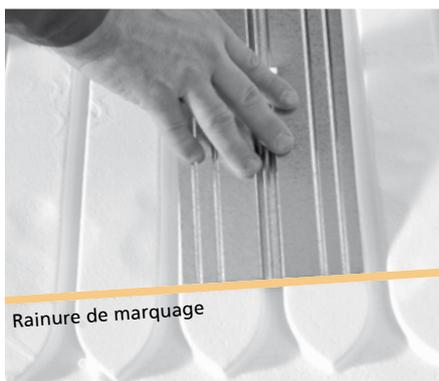
**Enfoncer les tôles de conduction de la chaleur** conformément aux intervalles de pose. Les appliquer contre la rainure de marquage de la plaque posée à sec 25 et les mettre l'une derrière l'autre en les espaçant de 5 mm. Il est possible de raccourcir sans outils les tôles de conduction de la chaleur aux points de rupture prédéfinis.
