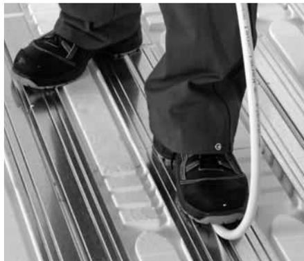
**Déployer le film de polyéthylène xnet T 200** avec la feuilure orientée vers la pièce. Fixer après l'avoir coupé à la bonne longueur. On obtient une piste de 2 m de large. Poser le film avec un recouvrement d'au moins 15 cm.
